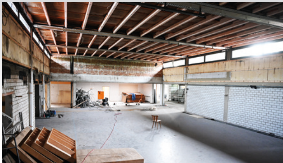
Fast schon ein bisschen gespenstisch wirkt es und ist kaum wiederzuerkennen: Das auf den Rohbau zurückgebaute Bürgerhaus in Schneppenhausen soll im Laufe des nächsten Jahres wieder in Betrieb genommen werden.
